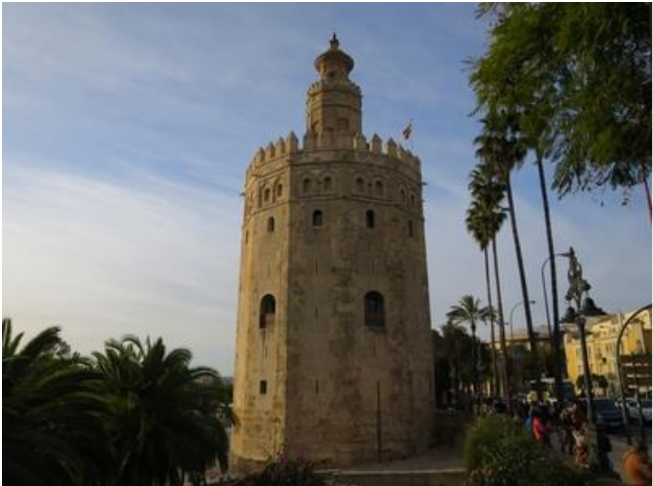
Kilometer 5,5: Der Wachturm "Torre del Oro" steht am Ufer des "Guadalquivir
